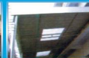
หลังคาโพลีคาร์บอเนตพร้อมเสริมแผ่นไฟเบอร์กลาสช่องแสง
